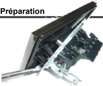
*Positionner le tournevis entre le mécanisme et la façade dans l'encoche prévue à cet effet et faire doucement levier à gauche et à droite pour déclipser la façade*
